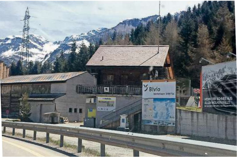
Die Bivio Sportanlagen AG baut im Sommer ihre Beschneigungsanlage bis Camon aus, um für den Winter gerüstet zu sein. (FOTO NADJA MAURER)
